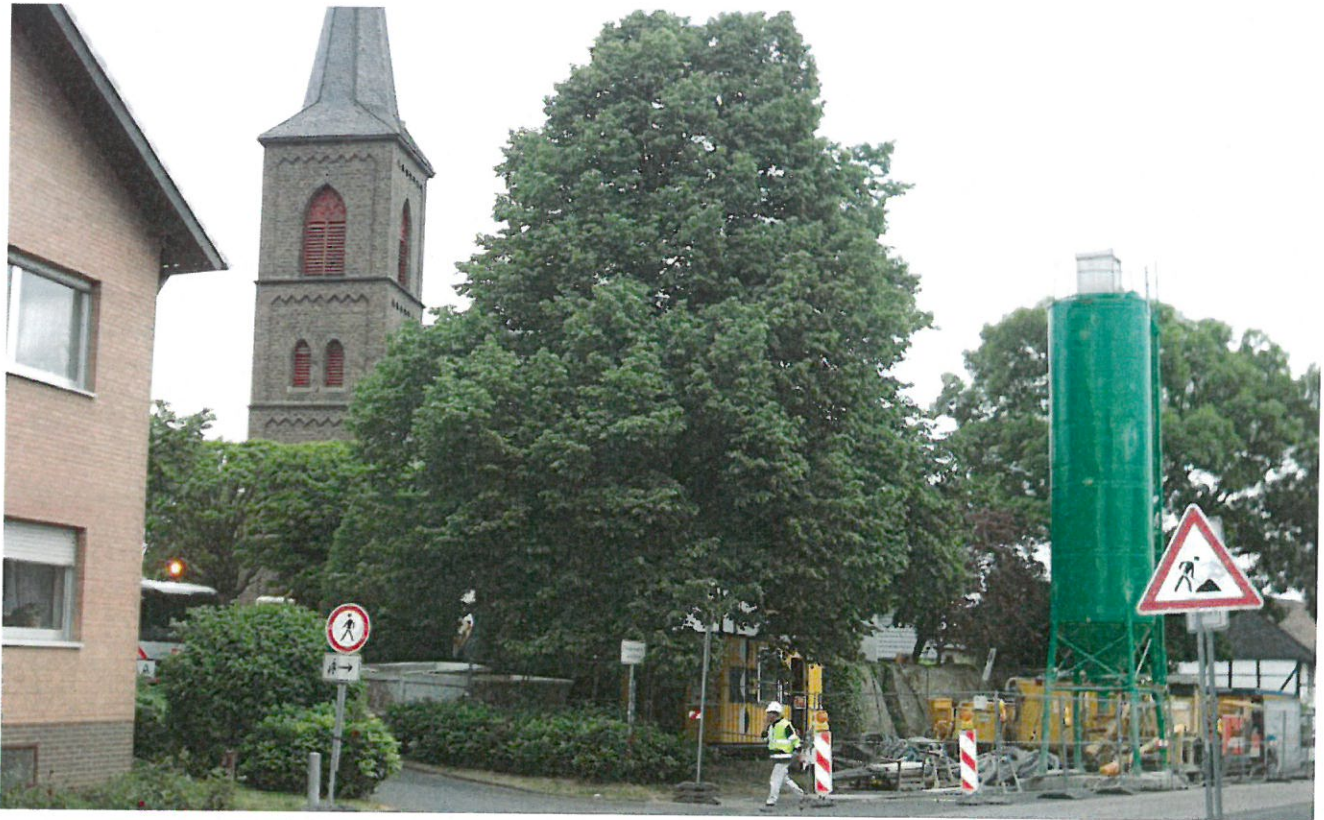
▲ Kreuzauffindung Elsig mit Baustelleneinrichtung für Düsenstrahlarbeiten
